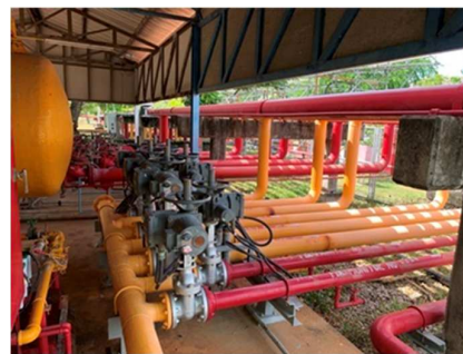
รูปที่ ข-27 ระบบโฟมอยู่บริเวณตรงข้ามกับอาคารทำการนายท่า โดยจะมีท่อโฟมส่งไปที่ถังเก็บน้ำมันทุกถัง
