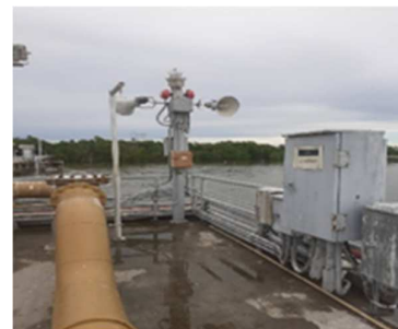
รูปที่ ข-8 เสาไฟสัญญาณที่ติดตั้งที่ท่าเทียบเรือ เพื่อให้สัญญาณแก่เรือบรรทุกน้ำมันเมื่อเรือเข้าเทียบท่า
