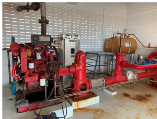
รูปที่ ข-25 เครื่องสูบน้ำดับเพลิง
