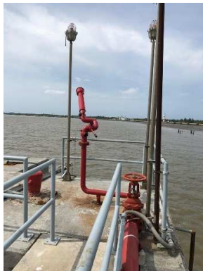
รูปที่ ข-20 เครื่องฉีดน้ำแบบตั้งอยู่กับที่
